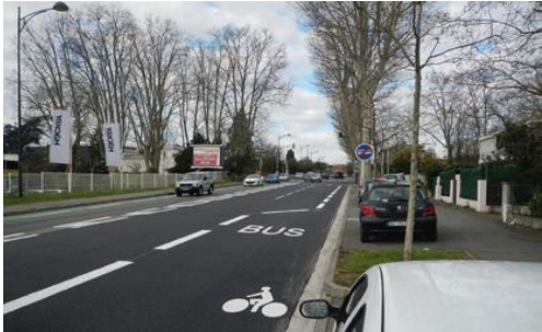
LINEO 9, Plus de couloirs bus, avec des priorités aux feux tricolores
